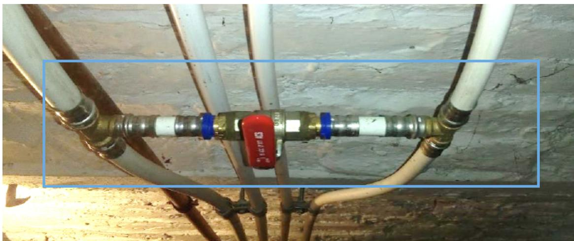
Ces vannes ne peuvent ni garantir l'étanchéité parfaite entre les deux circuits d'eau, ni prévenir la contamination bactériologique de l'eau.
